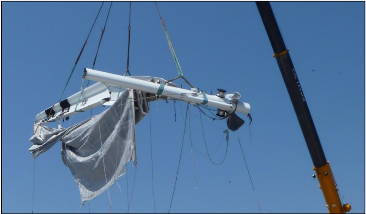
Débarquement du 1 er tronçon du mât et de la bôme
