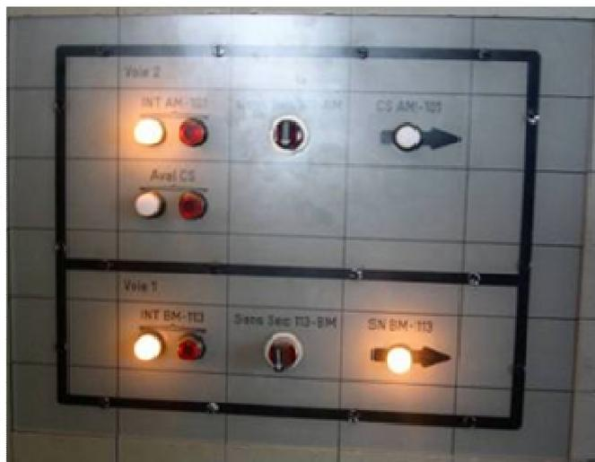
Figure 12 : Module spécifique IPCS intégré sur le TCO
